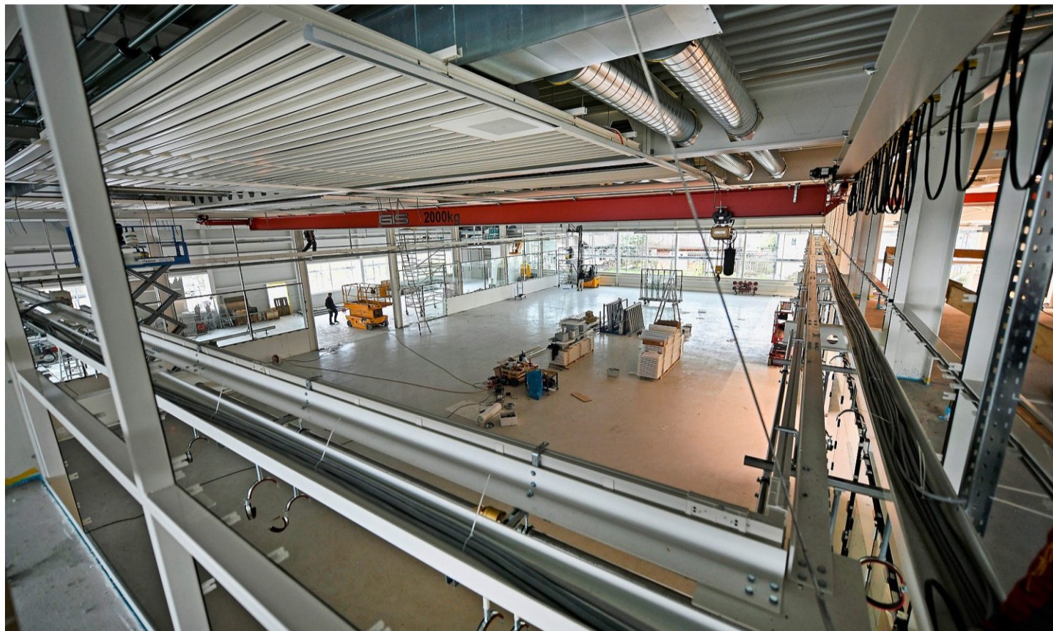
Kurz vor der Inbetriebnahme: Schon im November sollen die ersten Produktionsmaschinen in der neuen Werkhalle laufen. Fotos: Thomas Peter
